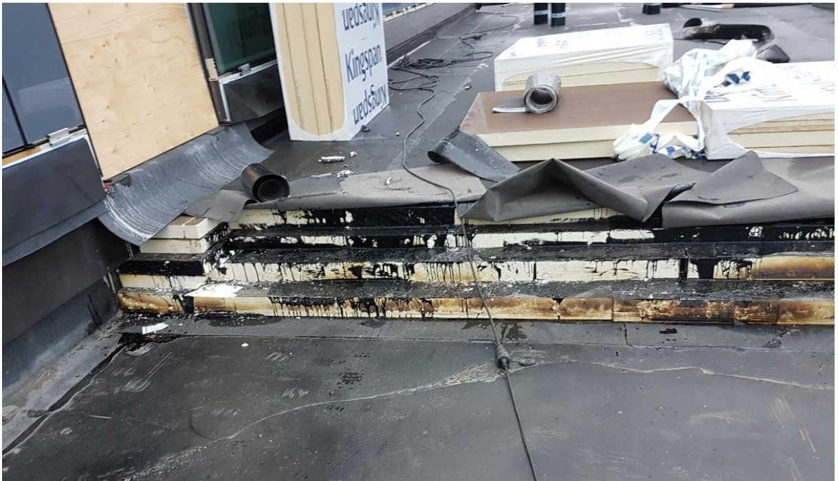
Figur 2: Exempel på kompakttak under uppförandet. PIR isolering används som helklistras och varje lager har förskjutna skarvar mot underliggande lager. Detta utförande ger ett kompakt skikt av tätskikt och isolering som minskar risken för fuktgenomträngning i konstruktionen.
