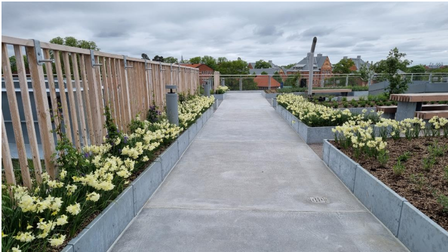
Figur 1: Exempel på en takterrass med olika typer av överbyggnader, gångvägar med beläggning av platsgjutet betong och grus samt planteringslådor och spaljéer mm.
