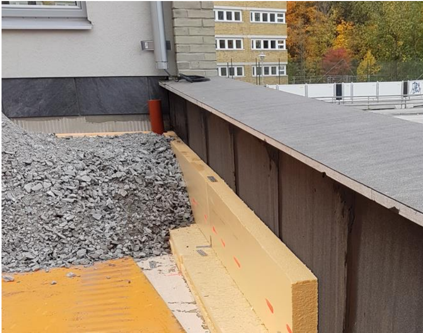
Figur 3: Isolering och påbörjad fyllning på omvänt tak. Fyllningen håller isoleringen på plats och skyddar isoleringen från brandpåverkan, därför är det en fördel att täcka över isoleringen så fort som möjligt efter utläggningen.
